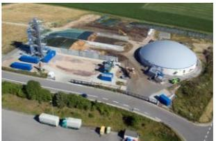
Produktion von Biomethan aus Biogas-CO<sub>2</sub> und grünem Wasserstoff mittels Power-to-Gas mit biologischer Methanisierung
